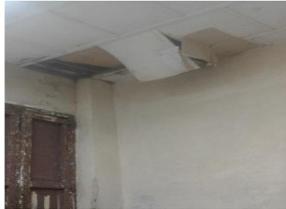
Figura 14. Locales con riesgo de humedad por filtraciones.
